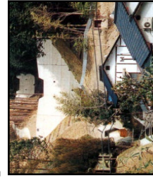
治山施設による山地災害の未然防止
